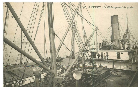
Le déchargement de grains de la soute du Navire 1909 (vue prise directement depuis le pont d'un steamer)
