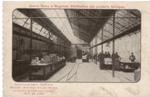
Vérification des produits fabriqués
