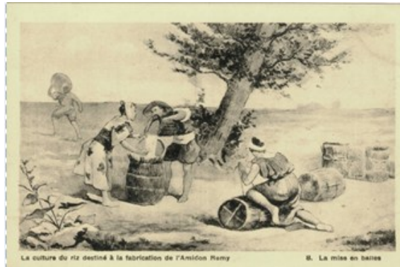
8 : La mise en balles
